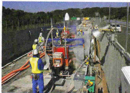
菊池川橋のWJ施工
